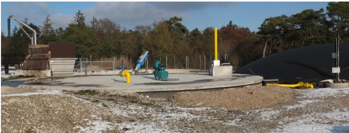
Abbildung 15-240: Ansicht der BGA57 mit Feststoffeintrag und Fermenter mit Rührgeräten (im Vordergrund) und Nachgärer mit Gasspeicherhaube (rechts im Hintergrund)
