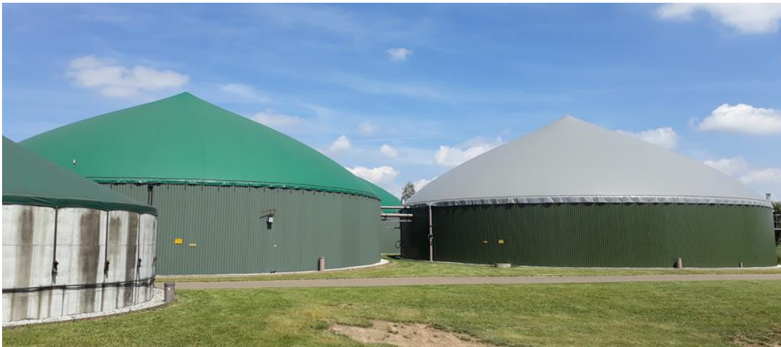
Abbildung 15-177: Anlagenansicht Fermenter und gasdichtes Gärrestlager
