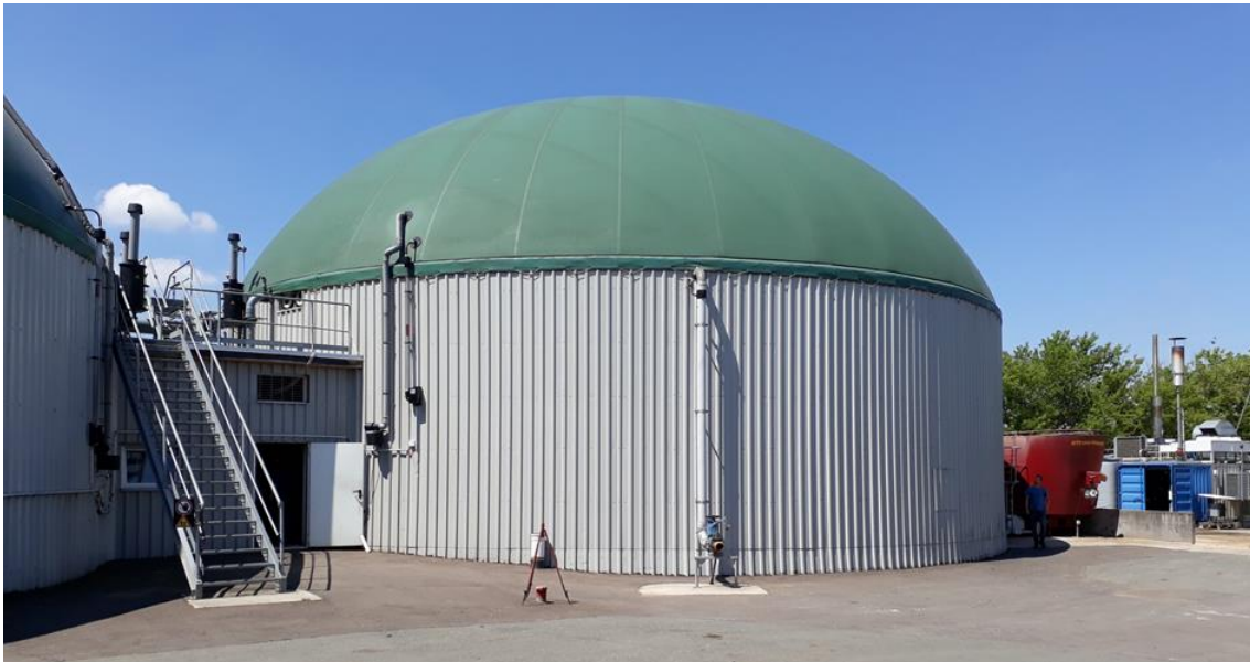
Abbildung 15-187: Anlagenansicht der BGA 44 mit Fermenter, Feststoffdosierer und BHKW-Container
