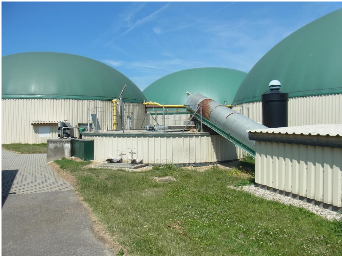
Abbildung 15-172: Fermenter 2 (links), Hydrolyse (Mitte vorn), Gärrestlager (Mitte hinten), Nachgärbehälter (rechts) der BGA 41
