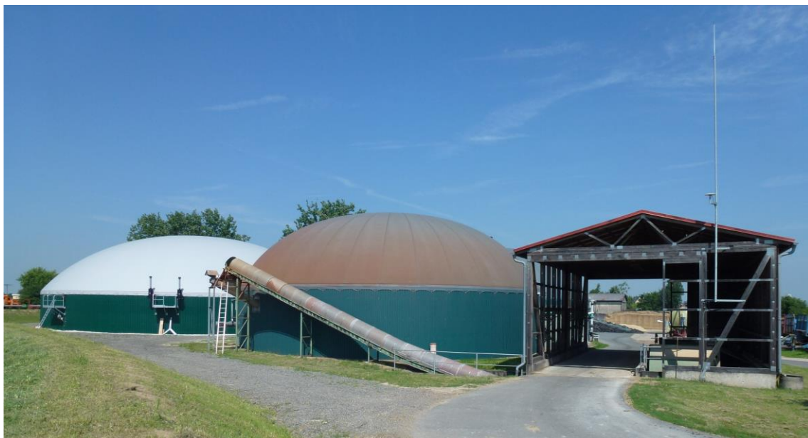
Abbildung 15-182: Feststoffdosierer, Fermenter1 und neu errichteter Nachgärbehälter (links) der Biogasanlage 43
