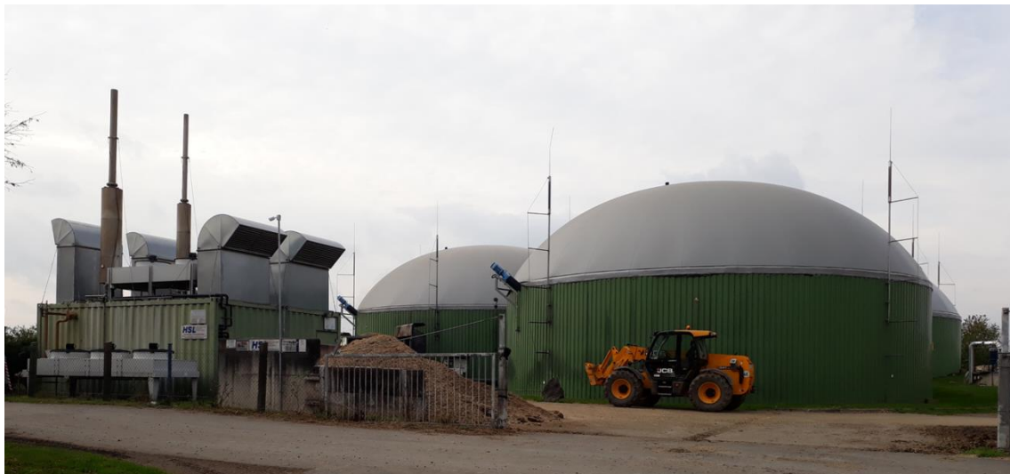
Abbildung 15-167: BGA 40 mit beiden Fermentern und BHKW-Modulen
