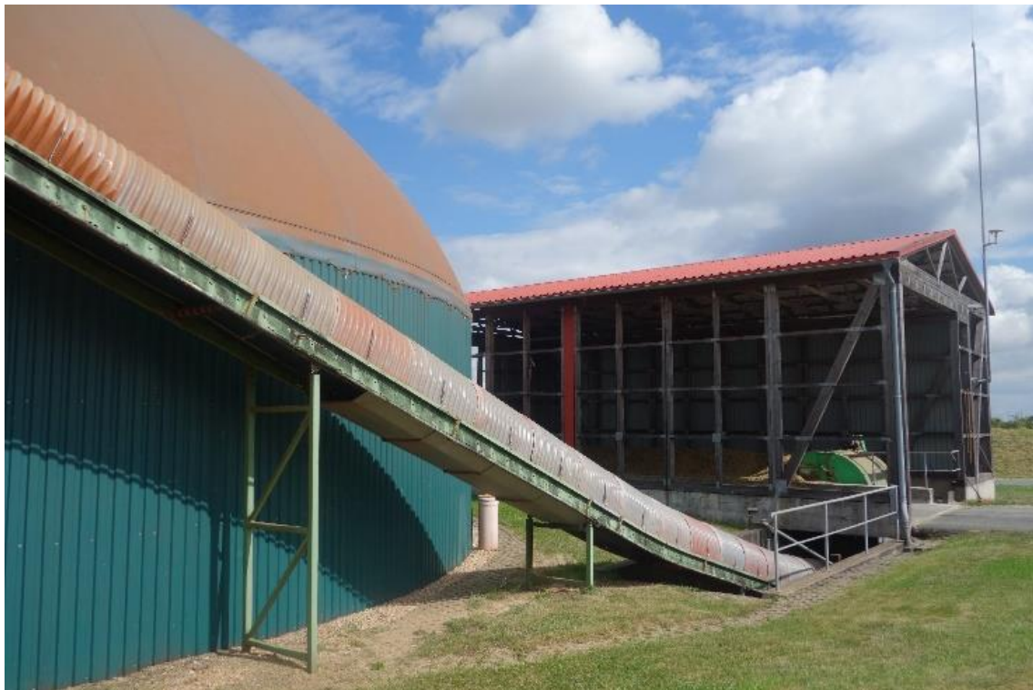
Abbildung 15-53: BGA 13 mit Fermenter, Feststoffdosierer und Förderband
