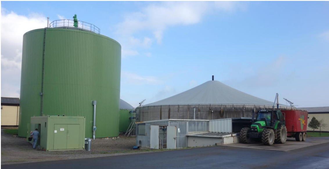
Abbildung 15-48: BGA 12 mit Annahmehunker, Pumpencontainer, Fermenter, Nachgärer (hinten) und Gärrestlager
