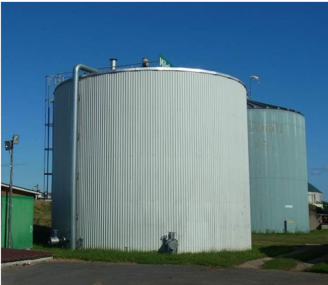
Abbildung 15-58: Anlagenansicht der Biogasanlage 14 mit Hydrolyse und Fermenter
